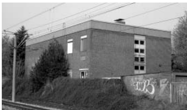
Abb. 28. Ortsvermittlung Oppum, Giesenweg. Baubeginn Mai 1970, Hochbaukosten 770000 DM; ab 24. Mai 1972 in Betrieb für 3000 Telefonanschlußmöglichkeiten und 1900 bestehende Anschlüsse mit Rufnummernänderung mit den ersten Ziffern „54“; Investitionen 1972 im Bereich Oppum (Vermittlungsstelle und Kabelnetz): 3,5 Mio. DM.
