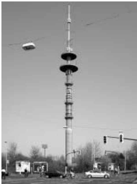
Abb. 38. Fernmeldeturm an der Violstraße, 102,4 m hoch, seit 1984 Betrieb.
