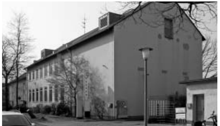
Abb. 24. Ortsvermittlung Pempelfurtstraße, ab 1958 in Betrieb; Kennziffer „3“; Gruppenvermittlung: übergeordnet für Fischeln (30), nach der Digitalisierung Muttervermittlungsstelle* für die Vermittlungsstellen Gatherhof, St. Tönis, Fischeln Lank, Strümp und Osterath.
