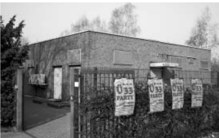
Abb. 23. Ortsvermittlung „Bockumer Feld“, Alte Krefelder Straße 68; Hochbau 1975 fertig, Inbetriebnahme 4. Dezember 1979. Kosten: Hochbau 1,1 Mio. DM, techn. Einrichtungen 2,7 Mio. DM, Kabel 1,0 Mio. DM; Kennziffer „4“, Gruppenvermittlungsstelle übergeordnet für Uerdingen und Rumeln (40); ab 29. Februar 1972 in Betrieb.
