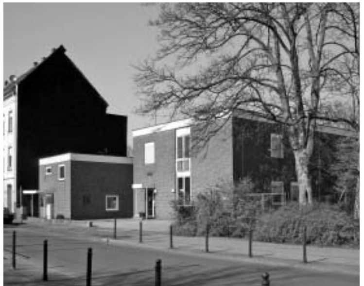
Abb. 35. Ortsvermittlung Inrath Straße, mit 3500 Telefonanschlüssen seit 1971 in Betrieb; Kennziffer „75“.
