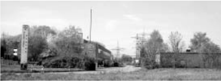
Abb. 32. Ortsvermittlung Gatherhofstraße (rechts). Baubeginn 1978, fertig Oktober 1983; Kosten über 4 Mio. DM, Hochbaukosten 800 000 DM; für rund 1800 Anschlüsse, Kennziffer „71“, links das 1972 errichtete Gebäude für den Fernmeldebaubezirk (anfangs mit rund 100 Mitarbeitern für den westlichen Teil von Krefeld für Anschlüsse und Kabel zuständig), dazu die Fernkabeldienststelle, dahinter das damals große Kabellager.
