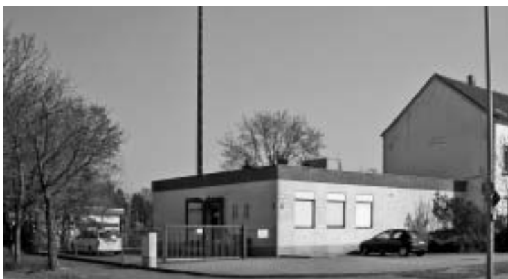
Abb. 29. Ortsvermittlung Verberg, Heyenbaumstraße. Baubeginn 14. September 1970, seit 8. August 1972 in Betrieb; Kosten: Hochbau 575000 DM, Technik 680000 DM und Kabel 650000 DM; 680 Anschlüsse umgeschaltet (neue, längere Rufnummern). Januar 1974 wurden vom Bereich Mitte 500 Telefonanschlüsse nach Verberg umgeschaltet und erhielten neue Rufnummern.
