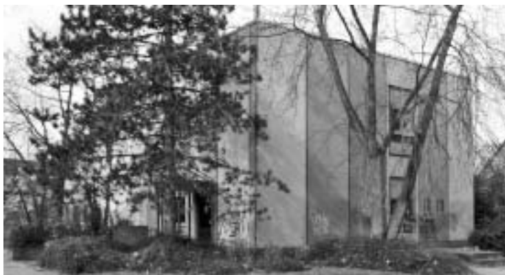
Abb. 25. Ortsvermittlung Fischeln, Wolferstraße (Wedelstraße); Baubeginn August 1972, in Betrieb seit 12. Februar 1974; 2000 Anschlüsse wurden umgeschaltet und erhielten neue Rufnummern mit 30 beginnend; vorher am 7. Februar 1974 Besichtigung unter großer Beteiligung von Vertretern des öffentlichen Lebens und der Politik; vor der Tür eine große Demonstration der Postingenieure für bessere Bezahlung und Einstufung, 13 x 25 m; mit Keller, 1 EG und 1 OG; Kosten: Hochbau 1,2 Mio. DM, techn. Einrichtungen 1,8 Mio. DM.
