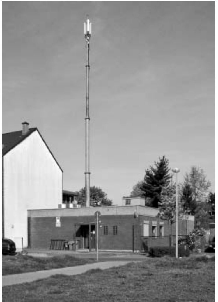
Abb. 34. Neue Ortsvermittlung Hüls, Josef-Heinrich-Straße. Hochbau fertig 1976; Kennziffer „73“.
