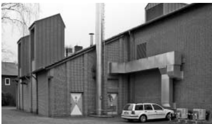
Abb. 27. Ortsvermittlung Germaniastraße; Beispiel für die Ausmaße der Kühleinrichtungen, die für digitale Vermittlungen erforderlich sind.
