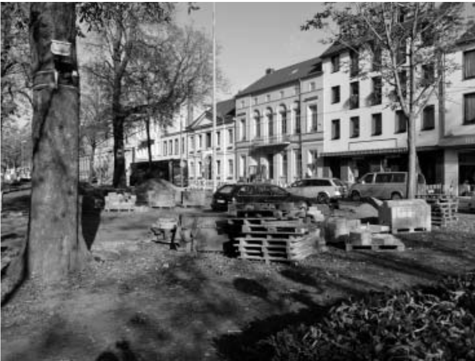
Abb. 2. Schrittweise aber stetig wird die Renovierung des Ostwalls fortgesetzt.
