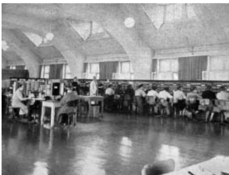
Abb. 13. Im Dachgeschoss des Telegraphenamtes: die Krefelder Ortsvermittlung (Hand) und das Fernamt (Hand)
