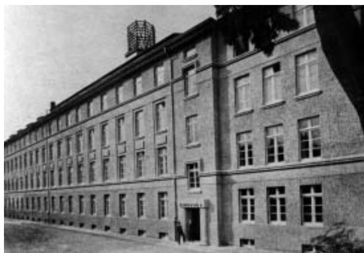
Abb. 14. Das Gebäude des Telegraphenamtes Krefeld (errichtet 1922 – 1924): Auf dem Dach erkennbar der achteckige Dachreiter, von dem die oberirdischen Blankdrahtleitungen zu anderen Dachreitern geführt wurden.
