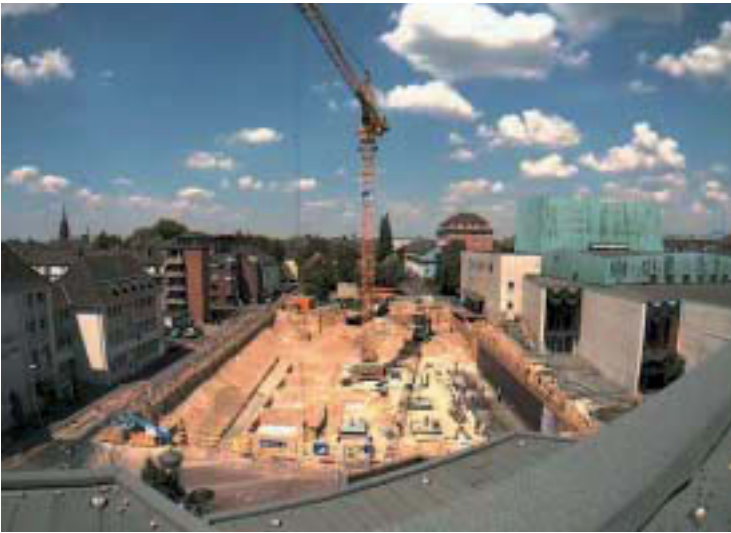
Abb. 2. Baugrube der Mediothek, vom Dach des Seidenweberhauses aus gesehen
