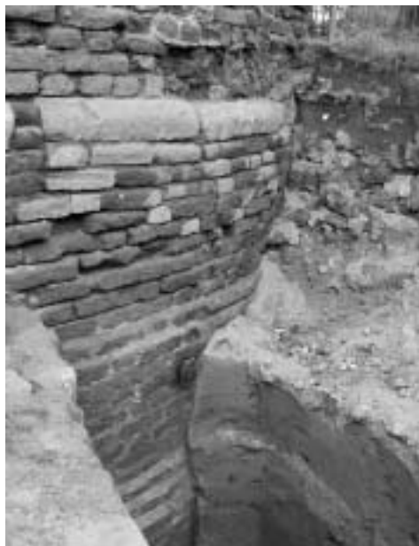
Abb. 3. Freigelegter Turmsockel mit Werksteinabdeckung aus Trachyt.
