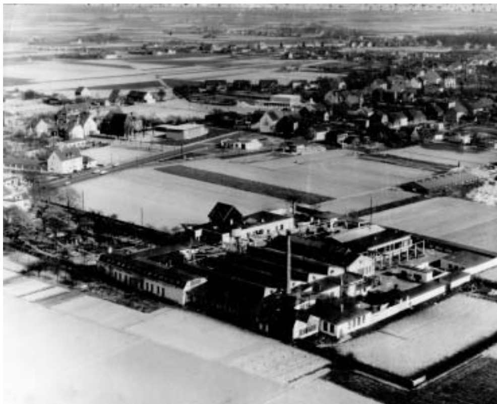
Abb. 3. Firma Robert Reichling, Luftbild aus den 1950er Jahren. Im Hintergrund ist die Kölner Straße zu sehen
