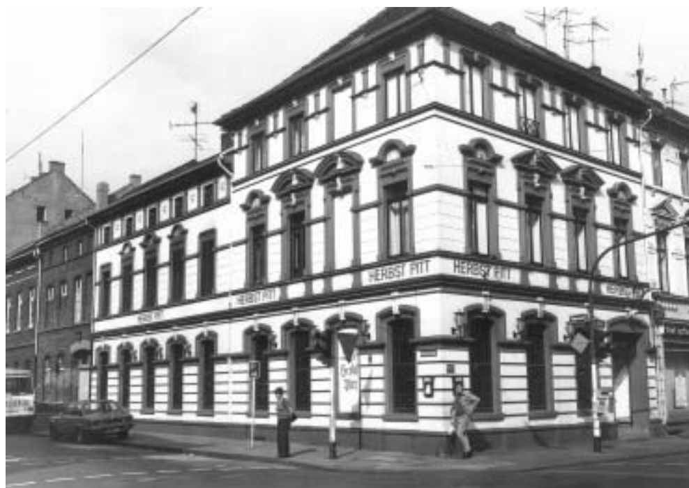
Abb. 12. Herbst Pitt 1979, Hubertusstraße/Ecke Marktstraße
