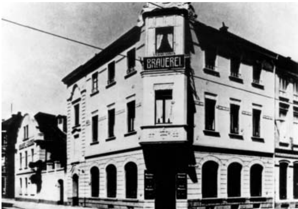
Abb. 11. Gaststätte und Brauerei Gleumes, Ecke Sternstraße/Nordstraße
