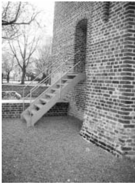
Abb. 17. Aussentreppe des Turms
