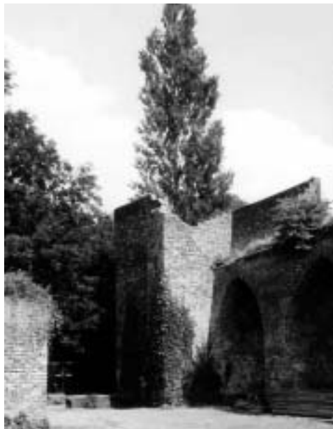
Abb. 15 a. Turm von der Hofseite vorher
