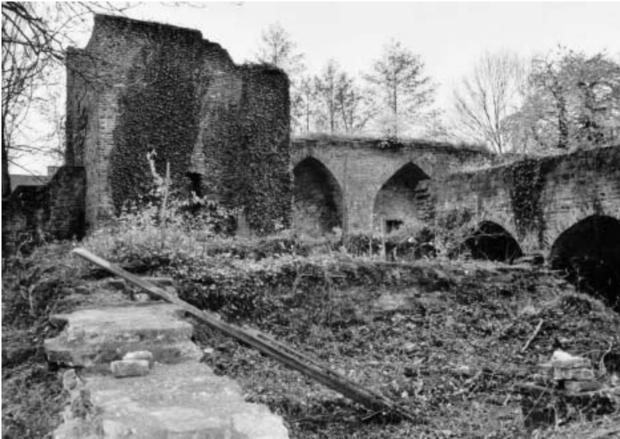
Abb. 20 a. Die Burgruine vor der Sanierung
